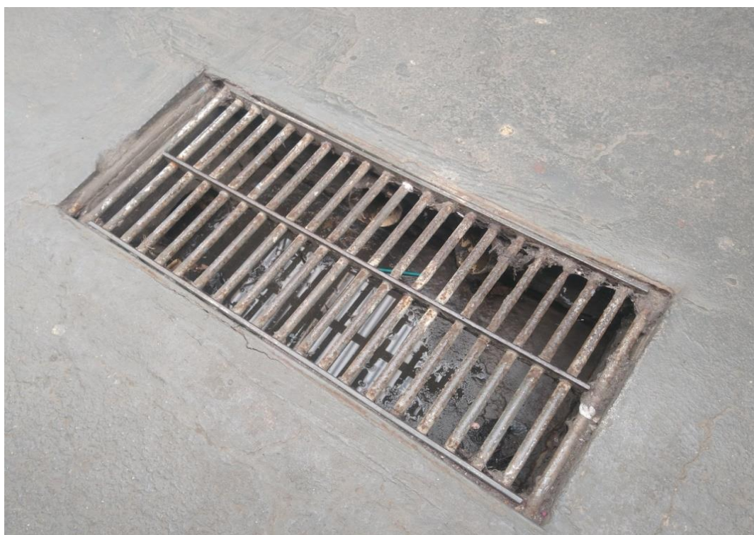
Grelha exposta no pátio
