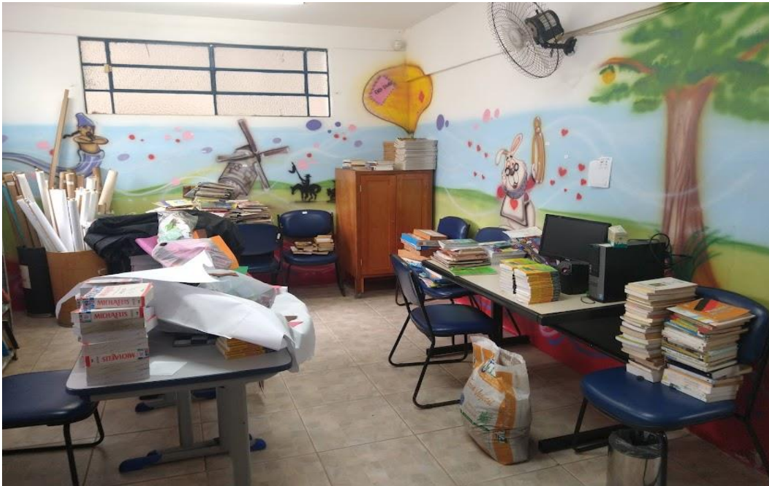
Biblioteca sem estrutura adequada
