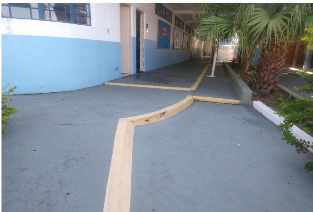
Existência de degraus em áreas de acesso o que dificulta a acessibilidade
