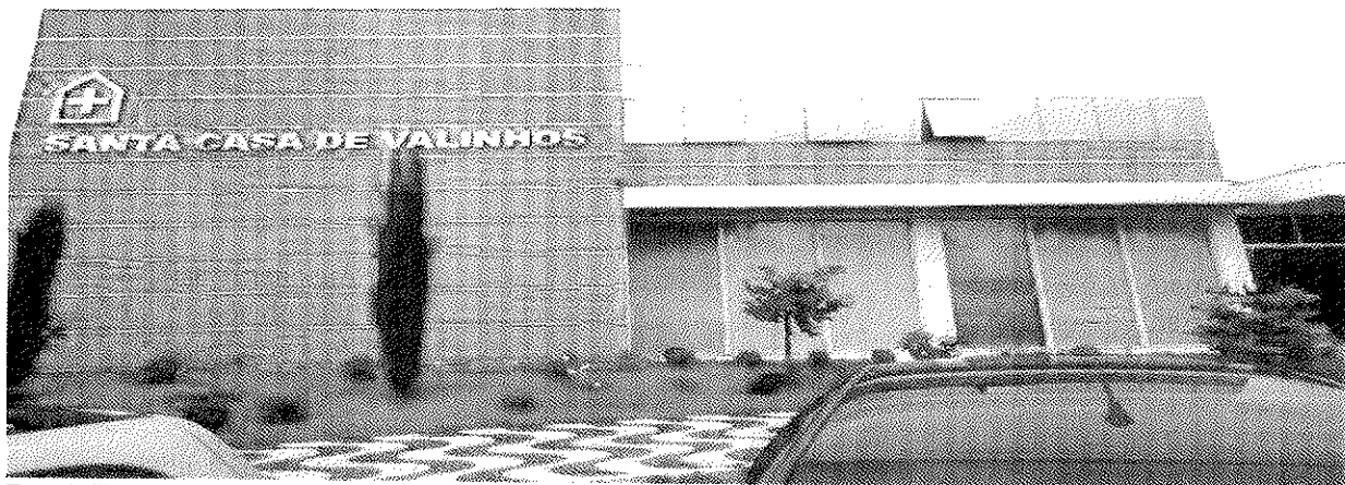
Foto 1: Entrada da SANTA CASA DE VALINHOS. Valinhos. Fev/17.
